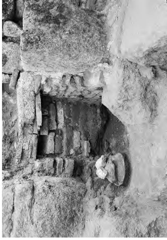
**Fig. 111 :** Ancien conduit de chaleur obstrué par un muret en briques sous la porte de communication avec l'espace sud (PCE 2005) (Chr. Bost).
