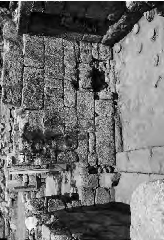
**Fig. 108 :** Couloir d'air chaud dans le mur nord de la pièce PCE1. Débouché du canal de chauffe (?) du *praeefurnium* (Chr. Bost).
